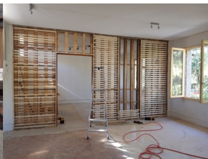
Fabrication des éléments de cloison
