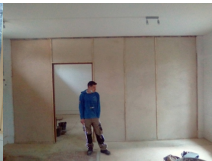
Enduit de finition (Léo)
